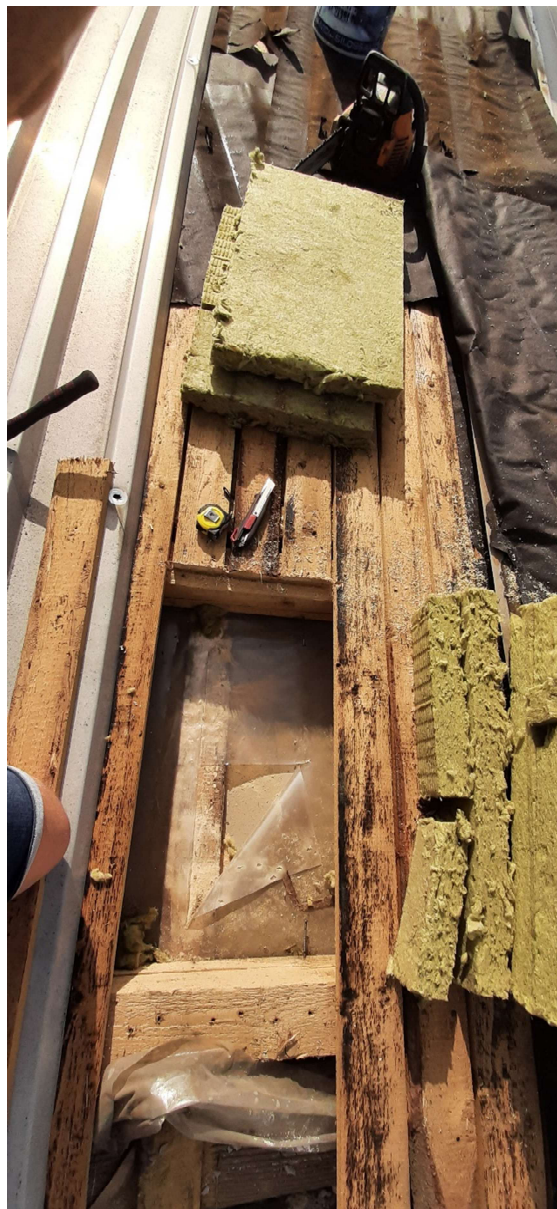
Obr. 2 – sonda v části krovu nad kabinetem
